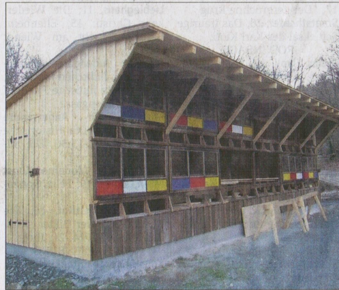
Bienenhaus mit besonderem Bautyp und den beachtlichen Maßen von 8,75 Metern Länge und 2,50 Metern Breite. Es wurde bereits 1937 errichtet.
